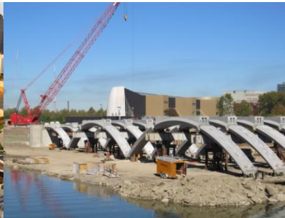
Precast rib arches
